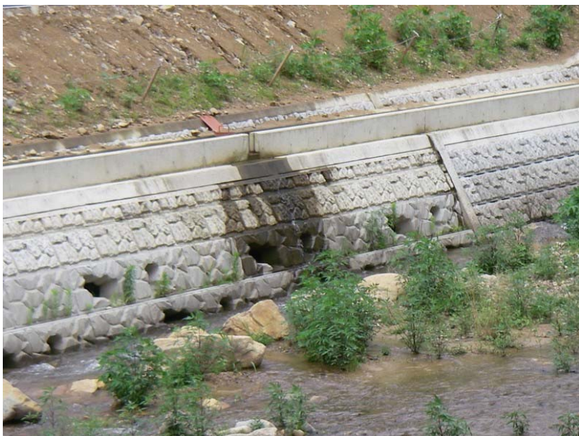
写真3 出石川の多孔質な護岸
