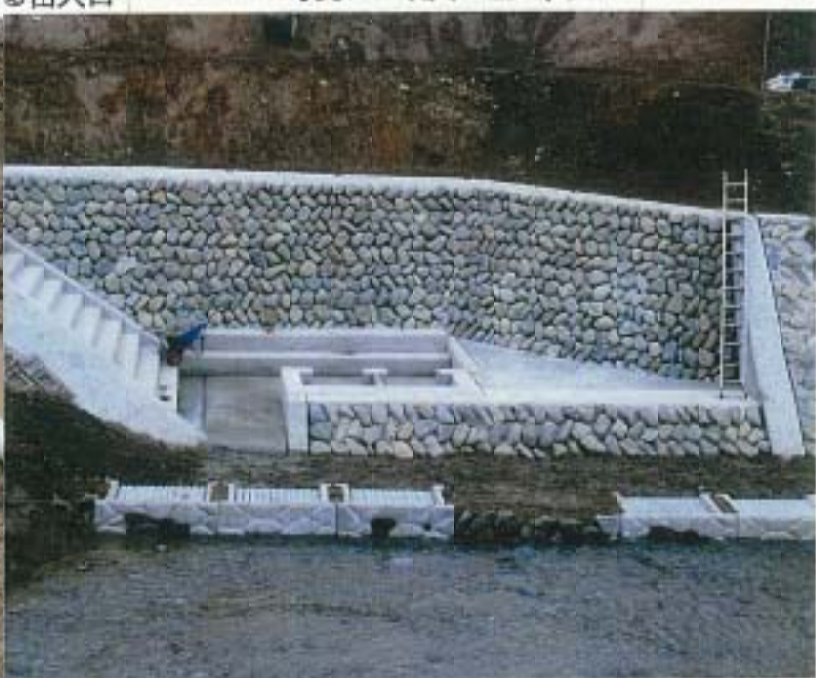
写真4 ほぼ完成した観察施設
