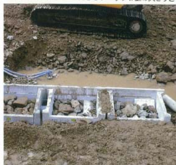
写真3 はんざきブロックの内部状況
