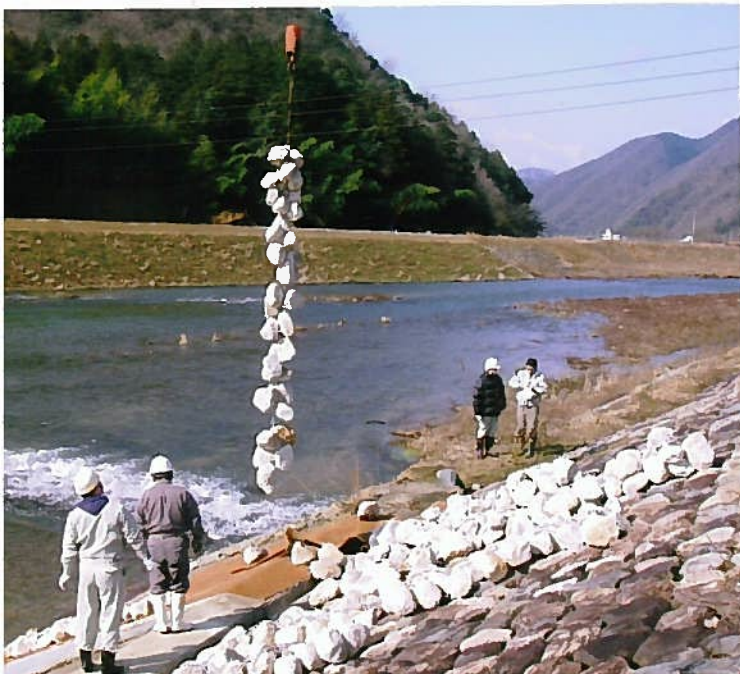
写真3 出石川で”すずかけ”の設置工事
