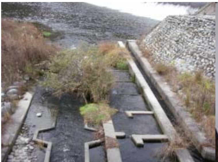
写真3 揖保川吉島統合頭首工・左岸の魚道視察
