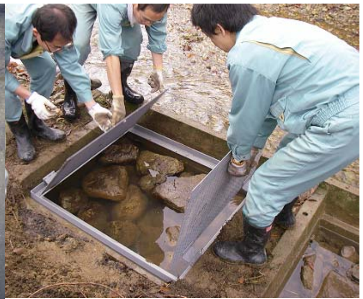
写真6 はんざきブロック内部観察用の蓋
