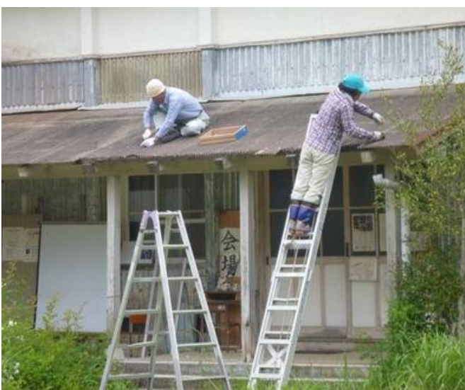
写真4 屋根の修理ボランティア
