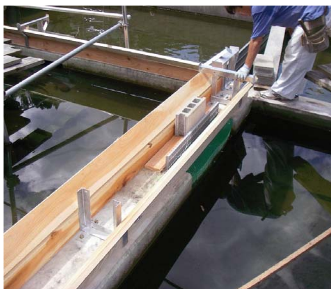
写真4 ハンザキ保護センターの脱走防止工事
