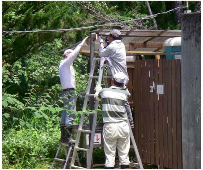
写真2 仮設トイレの屋根の補強
