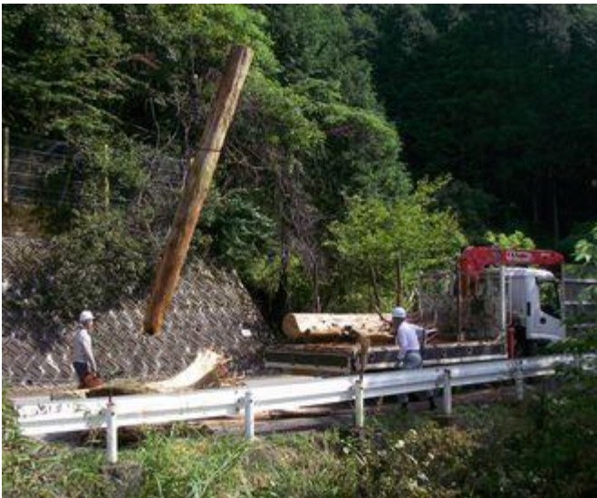
写真 9 流木の撤去作業
