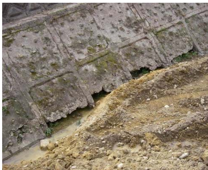
写真3 古い護岸の裾の空間
