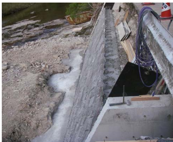
写真5 コンクリで固められた工事
