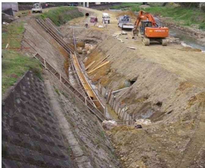
写真2 ハンザキが発見された工事現場
